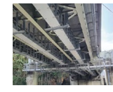
主桁・床版一体型FRP検査路
