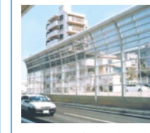
透光型吸音パネル(ビューゾーン)
