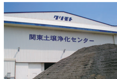
関東土壌浄化センター
