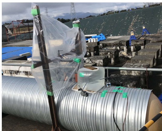
2. 屋外環境での荷重載荷時の試験状況
