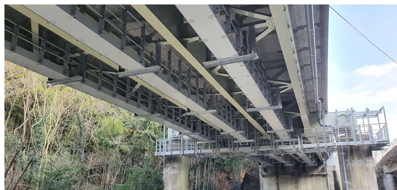
関門自動車道 山中高架橋
