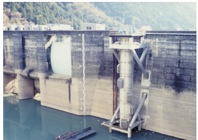
選取取水設備
