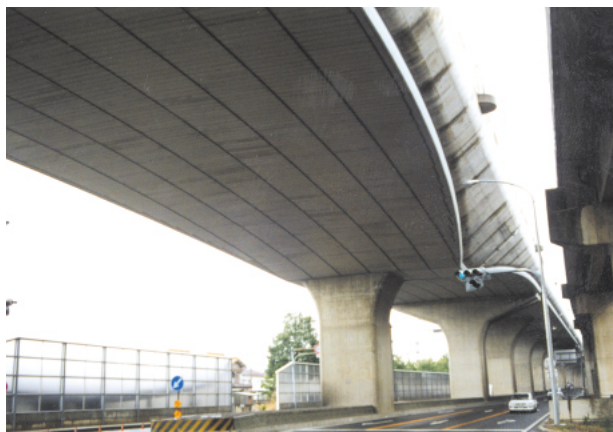
日本道路公団名古屋建設局302号味美高架橋裏面吸音板
