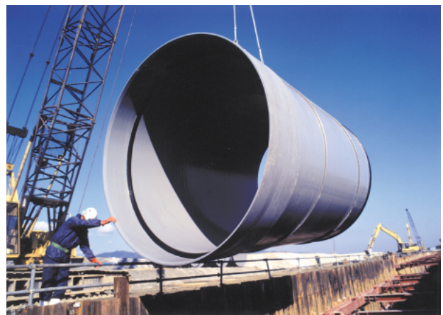
2800 FRPM管の据付け
