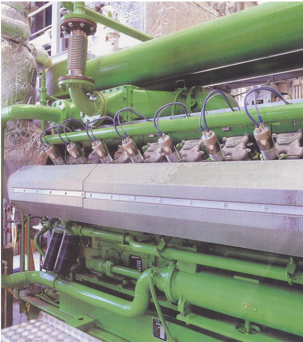
図4 ガスエンジン Fig. 4 Outline of gas engine
