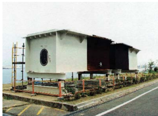
図2 当社大阪臨海工場に設置した実験桁
