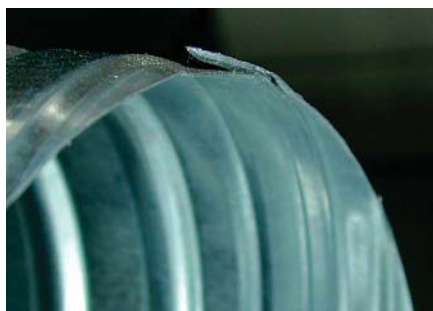
図12 ハゼ Fig. 12 Lock seam
