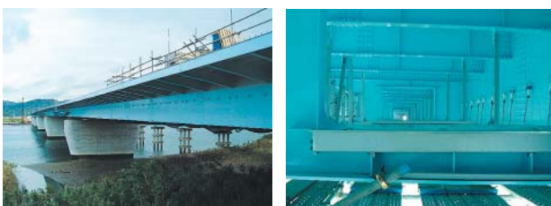
図5 橋梁外観と布設前の状態
