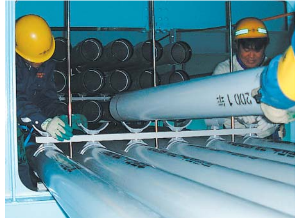
図6 FRP管布設
