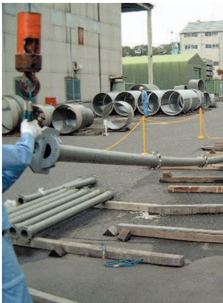
図5 吊り上げ状況
