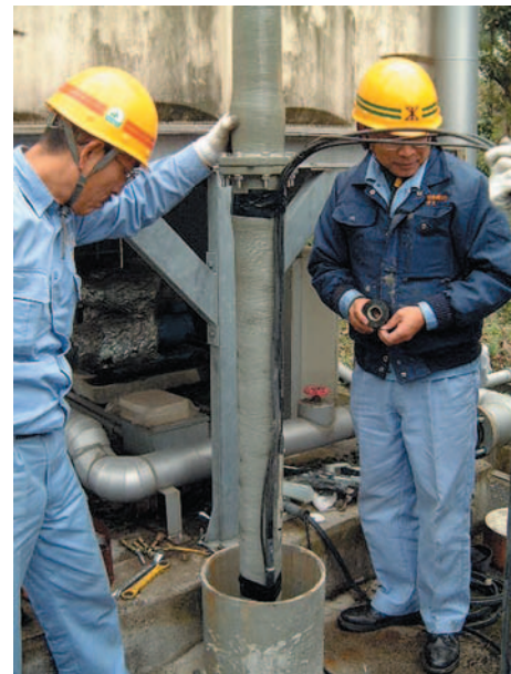
図8 順次挿入状況
