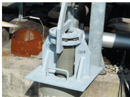
図6 専用吊り上げ治具使用状況
