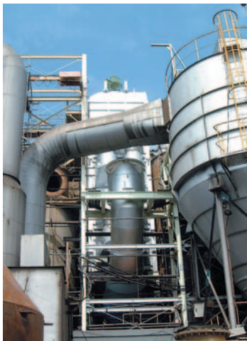
図8 新型空気予熱器 Fig. 8 New recuperator
