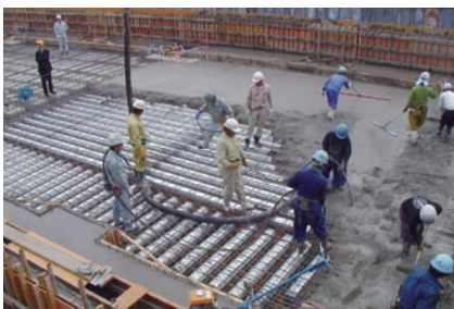
コンクリートの打ち込み →
