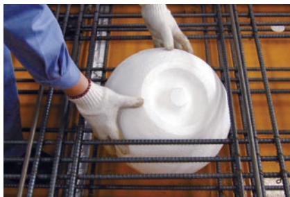
ボイド型枠の据付け 1 →
