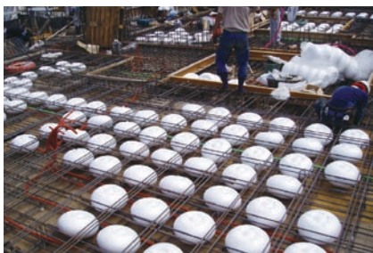
ボイド型枠の据付け 3 →
