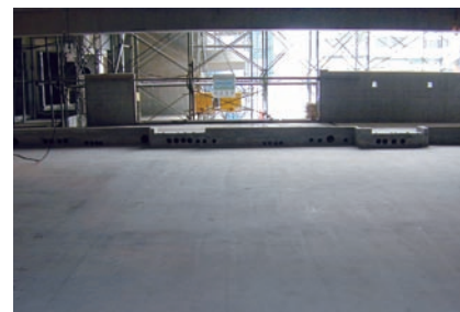
型枠脱型・養生
