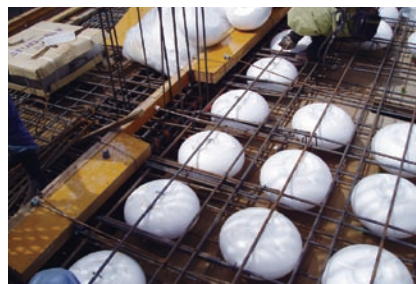
ボイド型枠の固定作業
