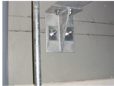
図9 ブラケット取付け
