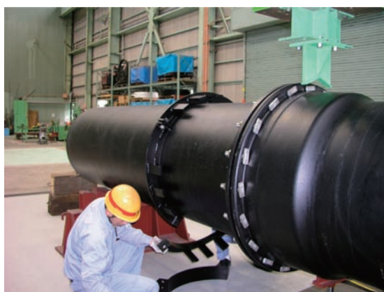
図20 作業員2名によるφ900スラストリング取り付け状況
