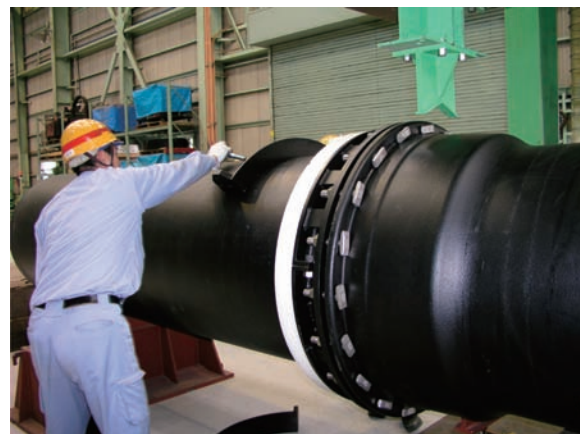
図21 作業員2名によるφ900EPSリング、サドルバンド取り付け状況
