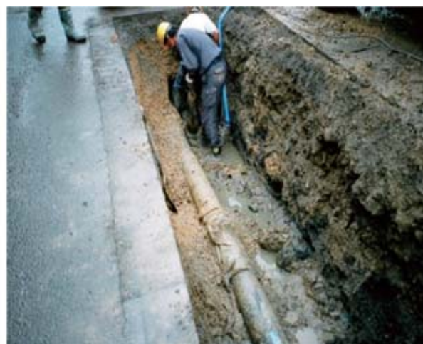
Zn-Al 擬合金溶射+合成樹脂塗装 φ200
