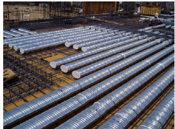
図2 クリモト中空スラブ施工状況
