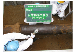
図3 付着物除去作業（ワイヤブラシ）
