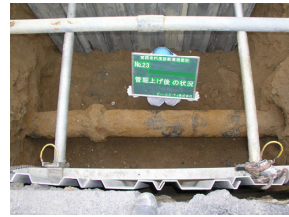
図2 堀上直後の調査管
