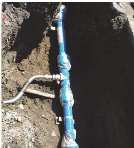
図12 給水管接続後の給水分岐専用管 (マンホール回避のため給水管を屈曲させている)
