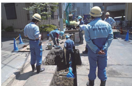
図11 試験施工状況
