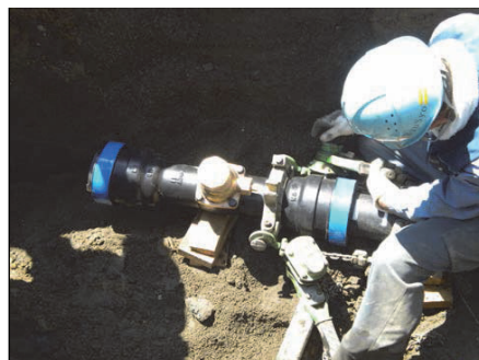
図13 給水分岐専用管接合状況
