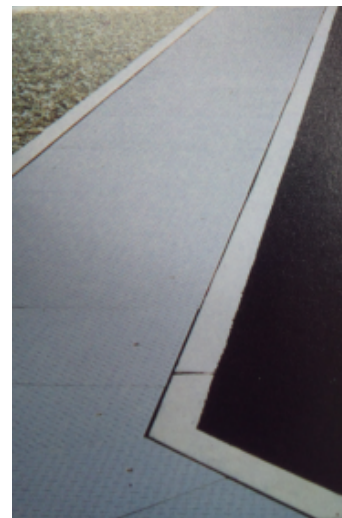
図2 FRPM板の設置例
