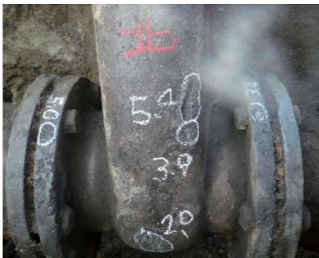
図7 仕切弁掘削・露出調査
