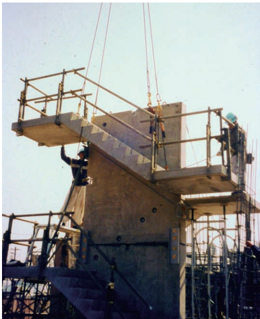
図4 システム階段の段床取付け
