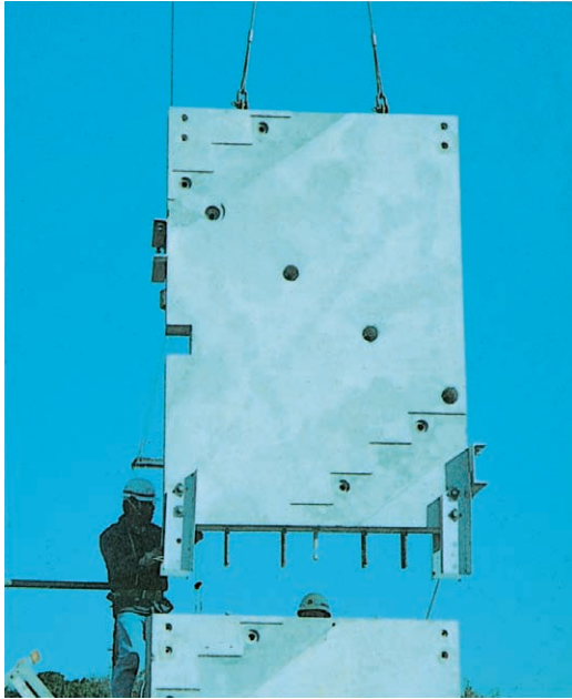
図3 システム階段の壁柱取付け
