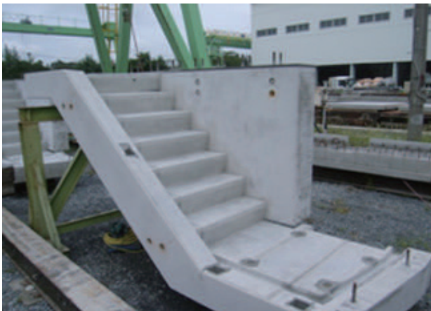
図1 壁・段一体化の階段
