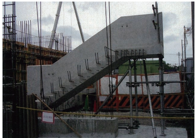
図2 壁が現場打ちの階段
