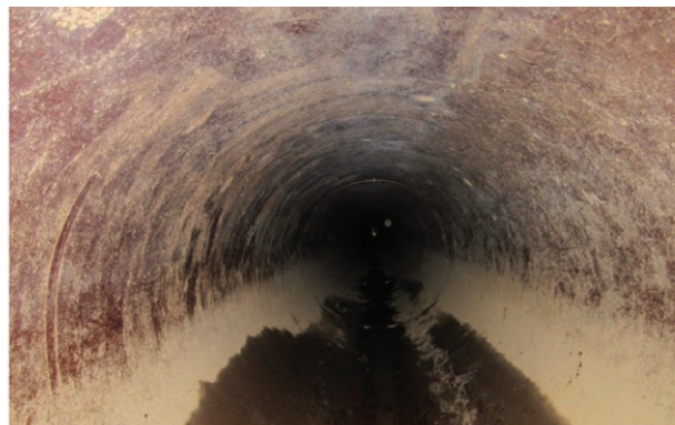
図8 実管路の管内面状況
