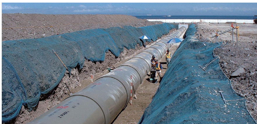
図1 FRPM管の施工状況
