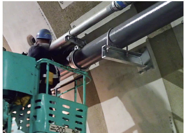
図21 継手接合作業状況
