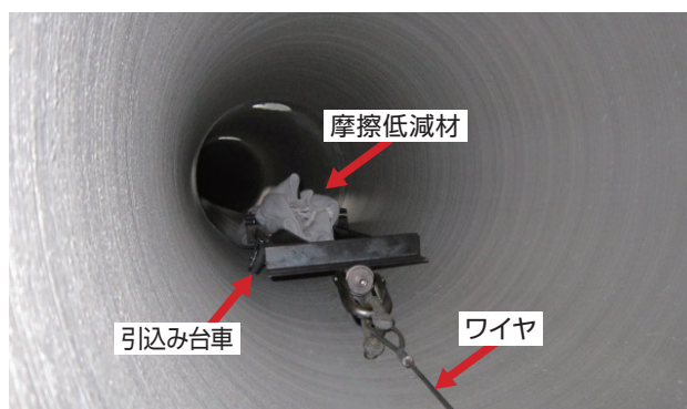
図 13 摩擦低減材 設置状況例
