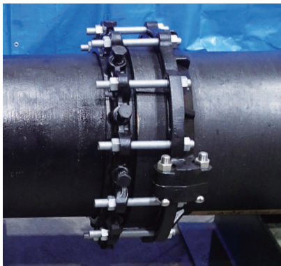
図5 T形直管への金具取付け状況(呼び径400の場合)
