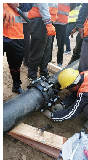
図10 ネパールにおける施工指導状況
