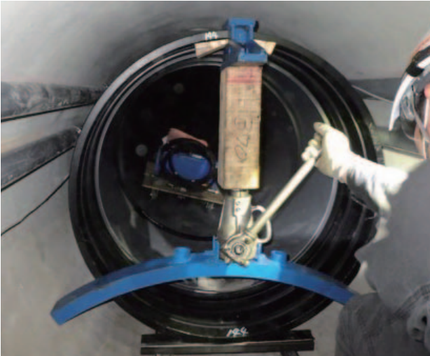
図20 管端部吊上げ状況（推進工法区間）
