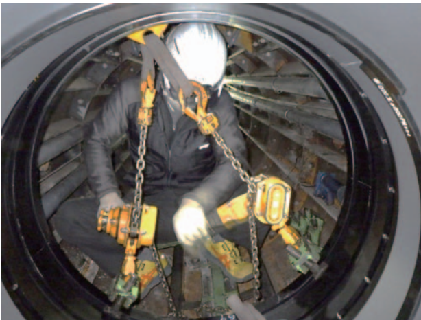
図21 管端部吊上げ状況（シールド工法区間）
