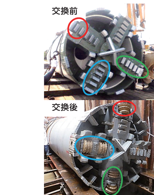
図13 ビット交換（ゲージ・インナーカッタ）
