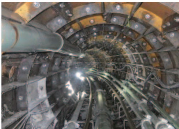
図15 シールド工法区間のさや管内の状況
