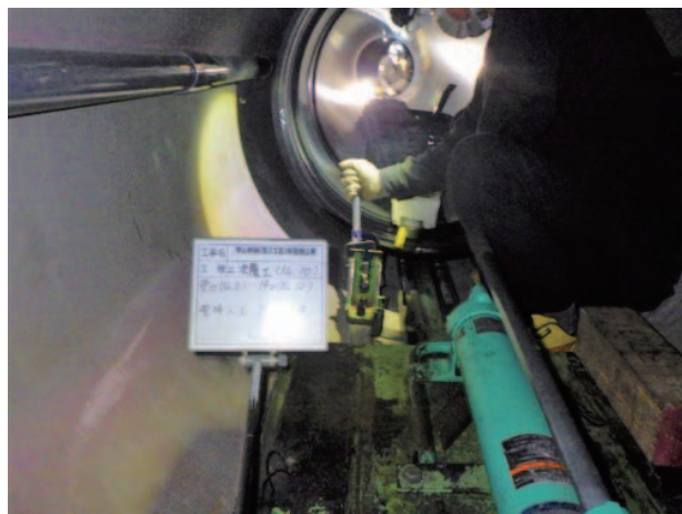
図19 PN形管の接合状況
