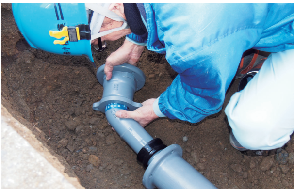
S50形ダクタイル鋳鉄管配管状況
