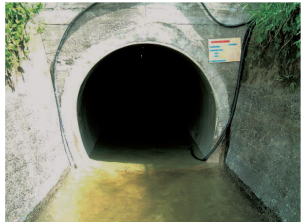
2r=1650 mm馬蹄形FRPM管施工状況
