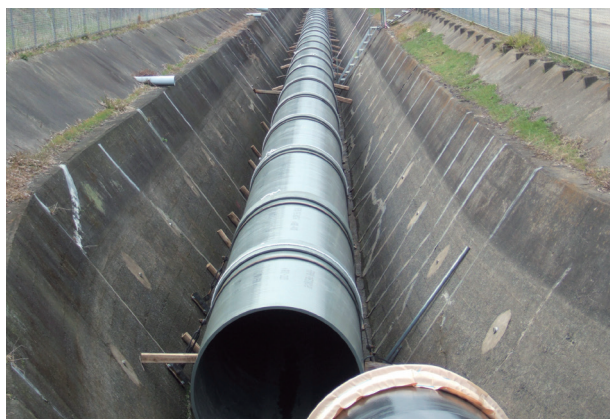
FRP (M) 管の施工状況
