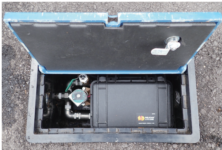
図 2 メータ BOX (口径 25 mm 用) 内への設置例
