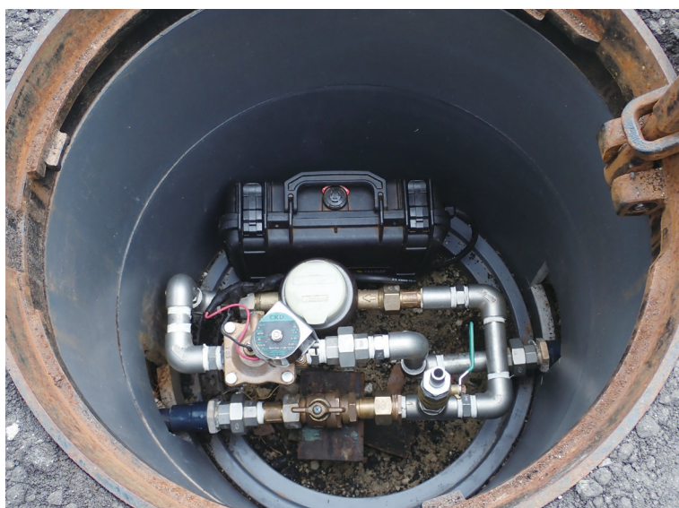
図 3 φ 500 弁室内への設置例
