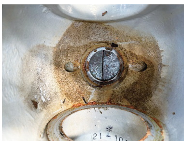
図 15 分解後の外弁箱内部
