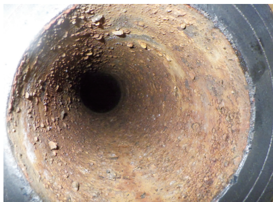
図12 上流側配管内部
